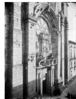
Fig. 4 – Portal principal da Sé do Porto antes da intervenção da DGEMN . Domingos Alvão. Casa Alvão, Sé do Porto, Porto, s.d., Arquivo de Fotografia do Porto – CPF/MC, cx820_Alv12.
