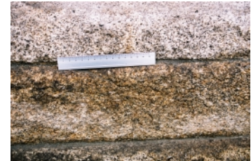
Fig. 3 - Pormenor , com escala, da tipologia de granito que dá corpo ao Portal da Sé do Porto. É possível perceber a junta de dois granitos de origem diferenciada.
