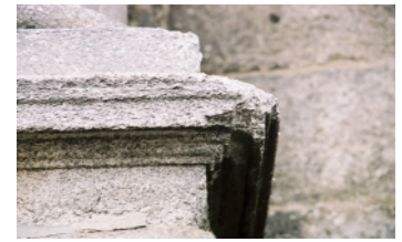
Fig. 5 - Sé do Porto. Base da coluna direita. Exemplo evidente de arenização, erosão regressiva com arredondamento das faces.
