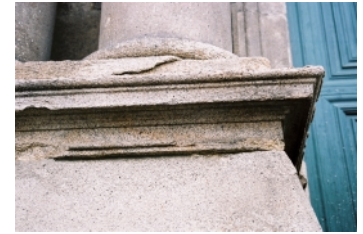
Fig. 8 - Sé do Porto. Remate superior da base do par de colunas do lado esquerdo. Evidentes lacunas e perdas.
