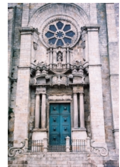
Fig. 2 – Portal da Fachada Principal da Sé do Porto. Fevereiro de 2002. Fotografia nossa.
