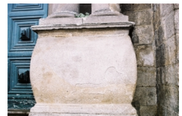
Fig. 6 - Sé do Porto. Base do par de colunas do lado direito. Fenómeno de lascagem, arenização e colonização biológica.
