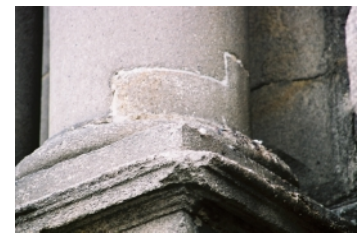
Fig. 9 - Sé do Porto. Coluna que integra o par do lado direito. Pormenor. Exemplo significativo de substituição.
